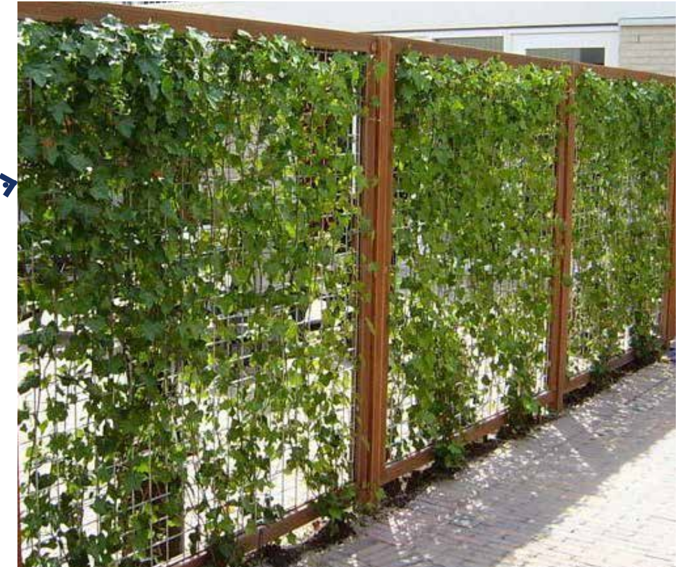
Betonijzere trellis met houten omlijsting als erfafscheiding, klimbeplanting aan binnenzijde
